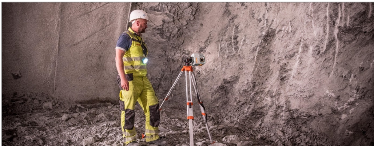
Abb. 01: Handheld Tunnel Scanner bei der Aufnahme einer Ortsbrust.
